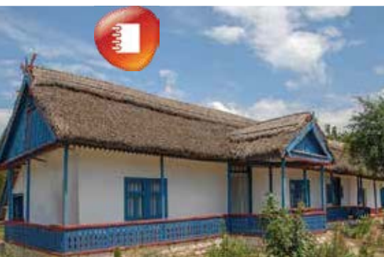
Fig. 9 – Casă tradițională din Delta Dunării, construită din cărămizi de chirpici (amestec de pământ, argilă, paie, apă, uscat la soare) și lemn, având acoperiș din stuf
